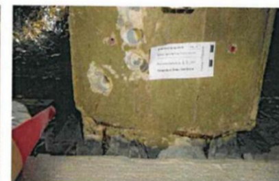
F+F / Soleo Heilbronn BT-A: Bauwerksuntersuchung 2022 BT-A---UG06.JPG;
